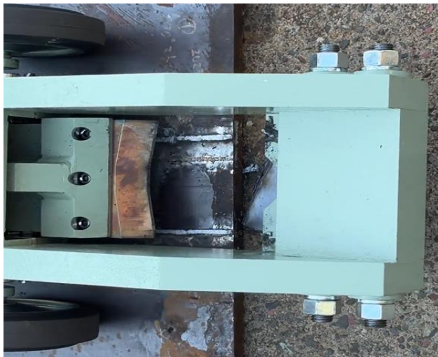
作業工程3 切断後
