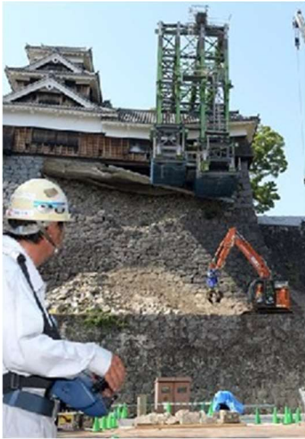
熊本城石垣撤去工事の現場
