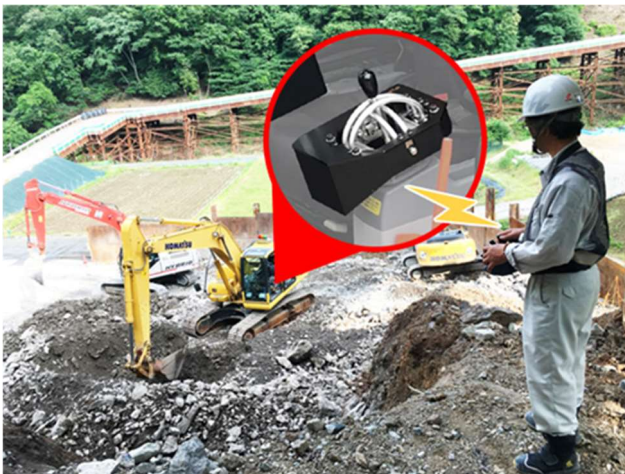
遠隔操縦中の様子
