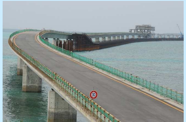
■伊良部大橋橋梁整備工事
