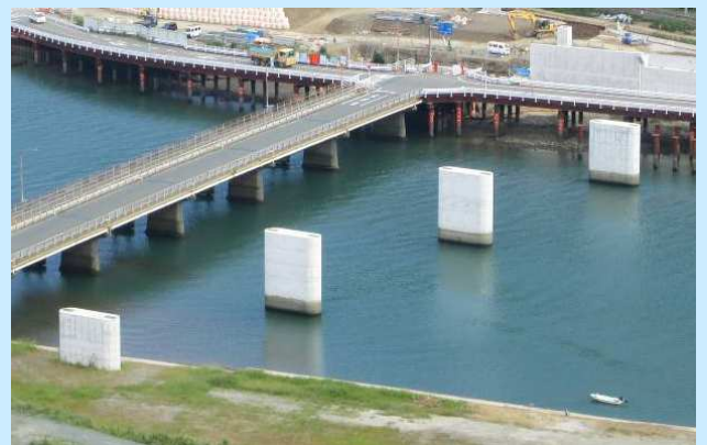
■大和橋下部工
