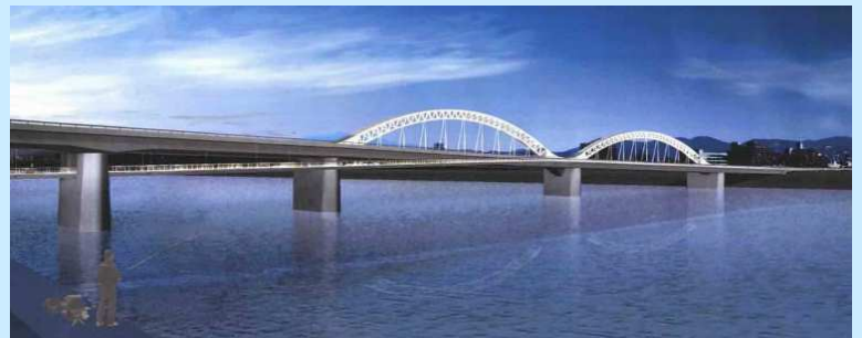
■広島南道路太田川放水路橋りょう
