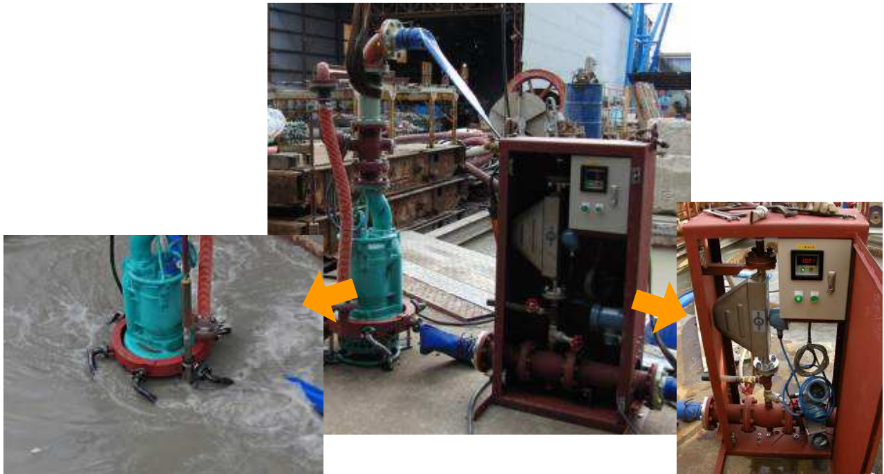
攪乱揚泥状況
