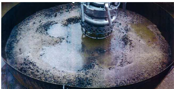
搅乱揚泥範囲 ポンプ中心φ2200mmの範囲を揚泥
